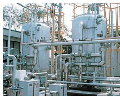
除鉄、除マンガン処理装置
